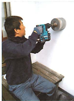
設置場所が決まったら壁を 貫通し給排気口をつくります。
